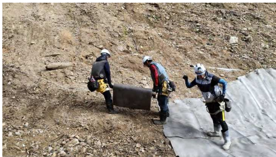
図 2.1.2 コンクリートキャンバス設置状況
