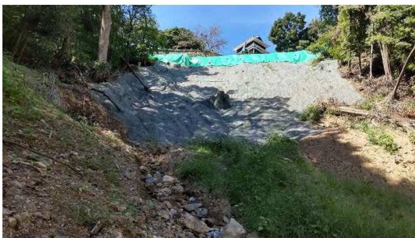
図 2. 1. 1 多機能フィルター施工状況
