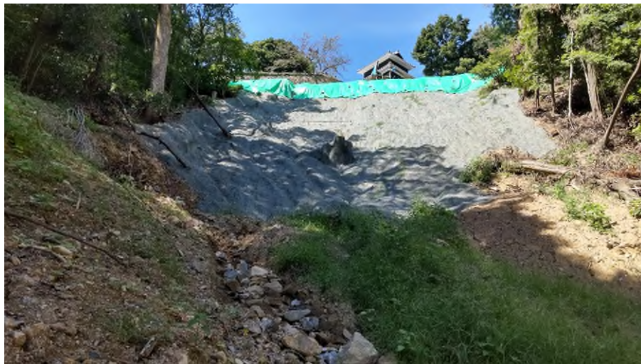
図 2.1.1 多機能フィルター施工状況
