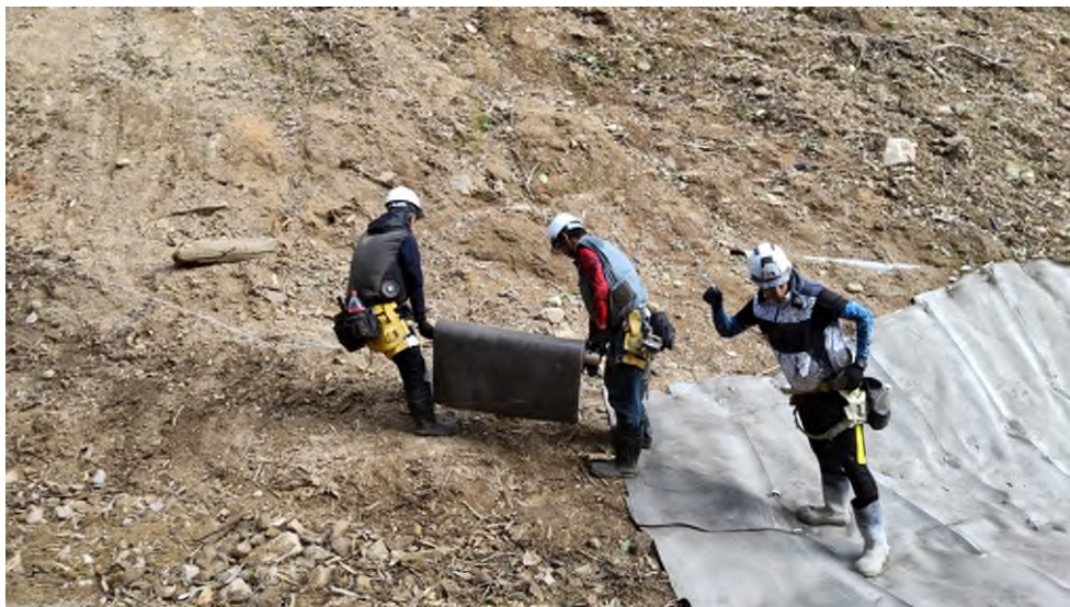
図 2.1.2 コンクリートキャンバス設置状況
