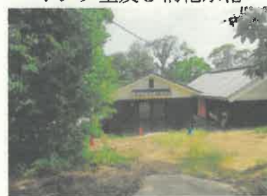
番号 M-55 施設名 ポンプ室及び消化水槽
