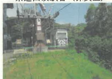
番号 M-53 施設名 索道山頂駅舎（係員室）
