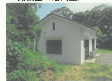
番号 M-56 施設名 機械室（電気室）
